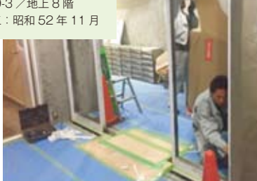
オートロック化の為、自動ドア設置工事
